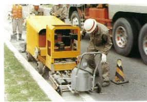
加熱方式による切削作業
