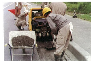
切削スリの処置作業
