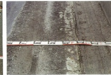
切削後の路面状況(切削幅50cm)
