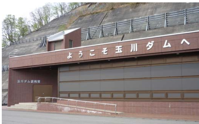
△玉川ダム資料館
