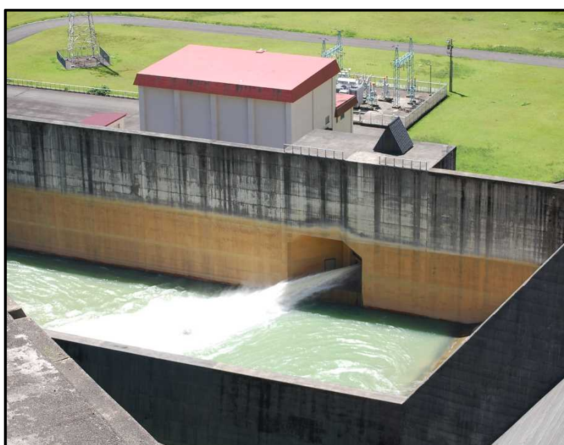
利水放流ゲート放流状況 約4 m 3 /s 放流
