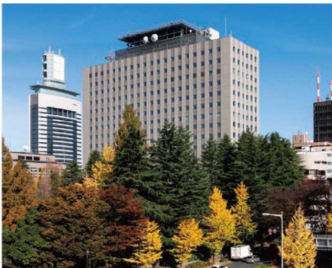
▲東北地方整備局(仙台合同庁舎B棟)
