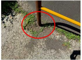
車止めを固定する穴に土が埋まっており、 車止めを固定できていないので、不安定な 状態になっている。
