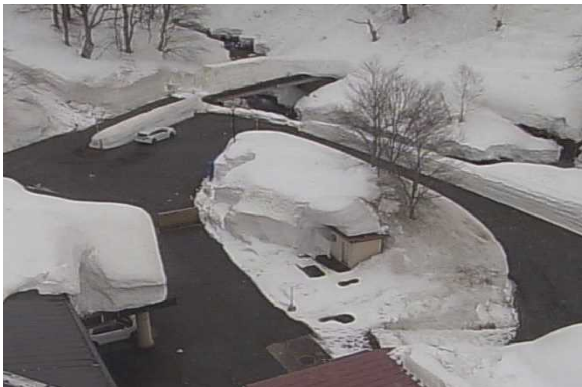
玉川温泉地点(中和処理施設)の積雪状況 4月2日9時時点
