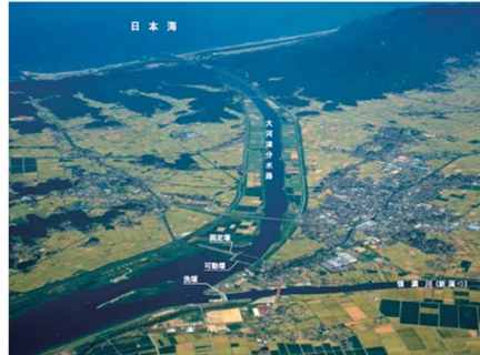
▲可動堰改修工事が進行中の 大河津分水
