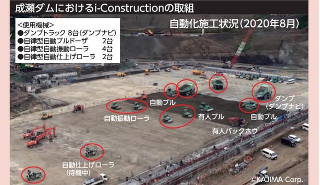
▲建設機械の自動化技術による次世代の建設生産システム
