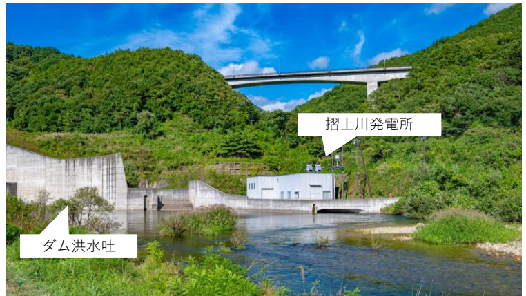
東北電力摺上川発電所
