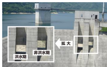
（写真は点検で放流口の両方がある状態）
