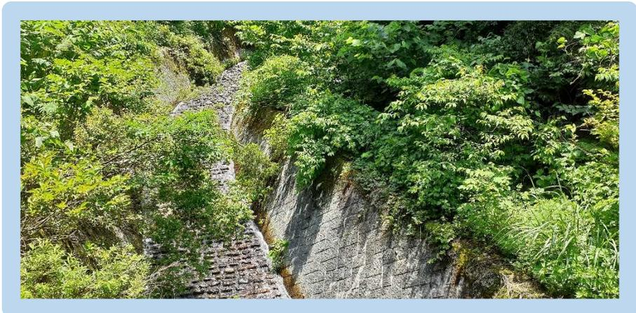
工藤沢砂防堰堤には、自然石を並べた流路工がつけられています。流水に変化をつけることで魚の遡上を助けます
