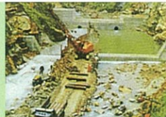
▲角川流域における 中沢ダム工事状況
