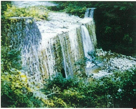
▲立谷沢川砂防発祥の地 第1号ダム (濁沢第一ダム・昭和12年着工) 「当時の工事費・29,800円」 現在もしっかり機能しています
