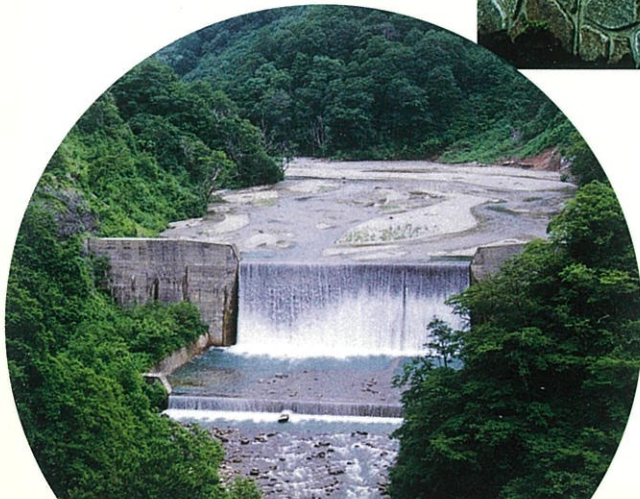
◀ 大規模な本沢第四ダム、砂防ダムは満砂してから洪水時には急激な土砂流出を調整し、下流における土砂災害を未然に防止する機能も備えています。完成は昭和50年11月、着手から完成まで8年も費やしました。
