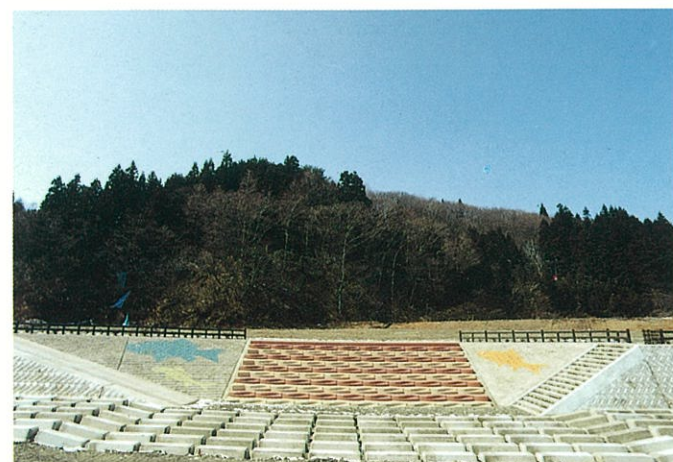
水とふれあう親水護岸（テラス護岸） 立谷沢川（木ノ沢橋左岸上流）
