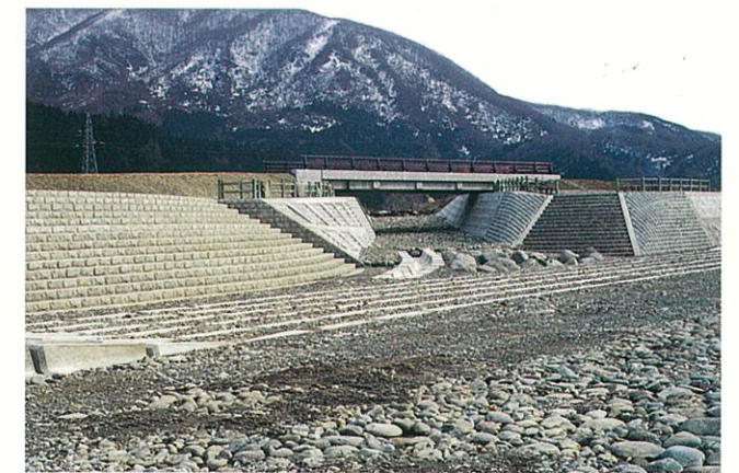
水とふれあう親水護岸（自然石を利用した護岸） 立谷沢川（木ノ沢橋右岸上流）
