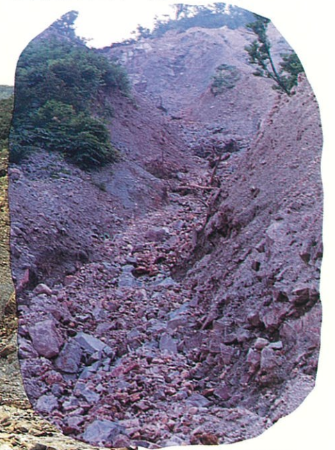
本沢上流崩壊地
