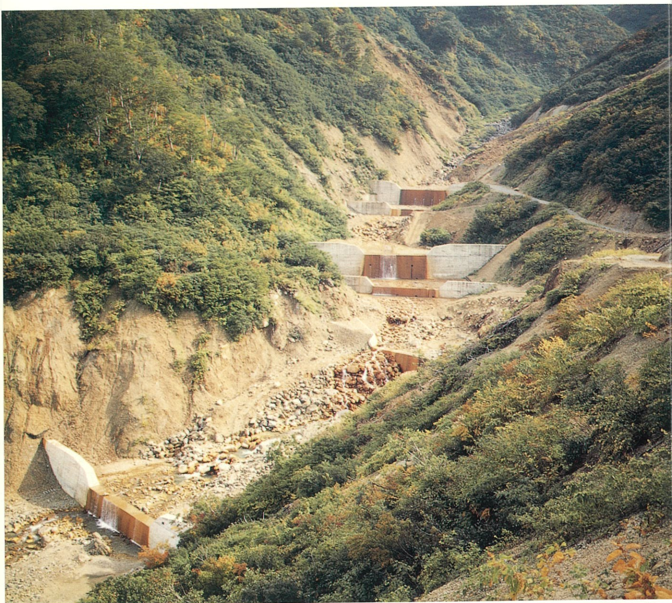
濁沢川の砂防ダム群
