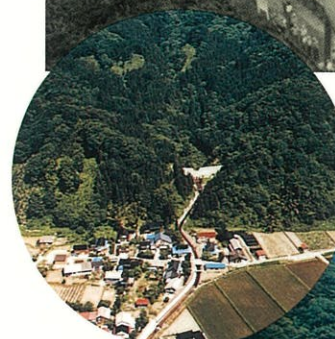
科沢地区を土石流から守る砂防ダム
