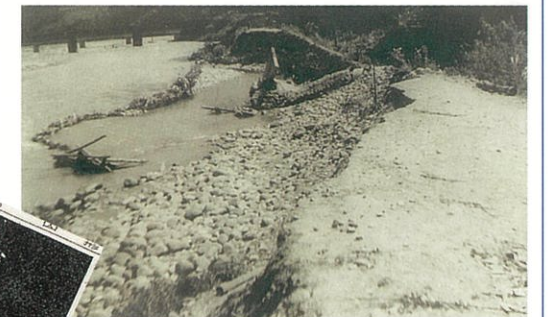
立谷沢川右岸堤防欠壊(昭和31.7.17)
