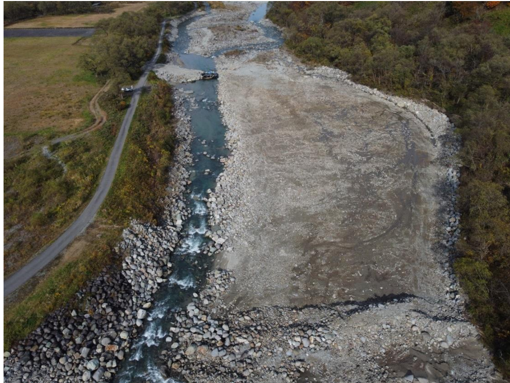
完 成 全景写真
