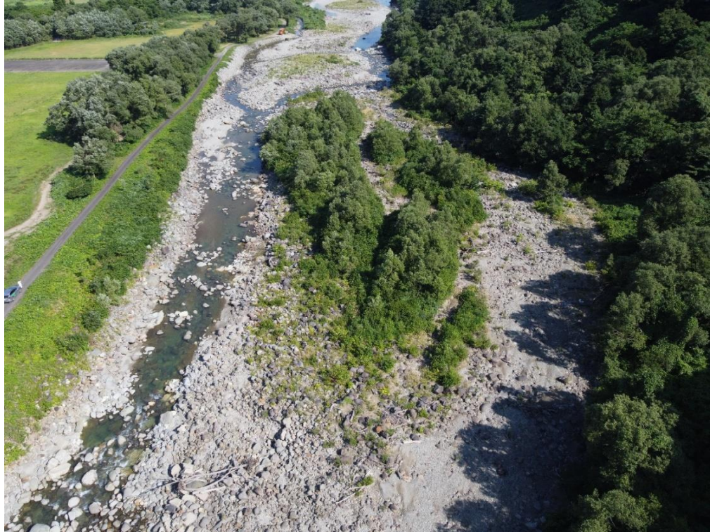
着工前 全景写真
