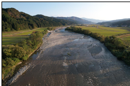
河道掘削箇所
