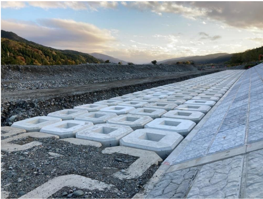
根固めブロック設置完成
