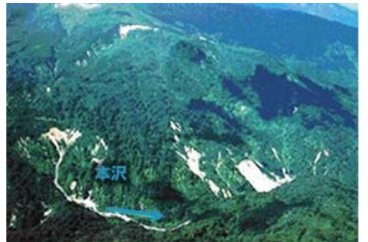
立谷沢川の上流、本沢流域の斜面の崩れ
