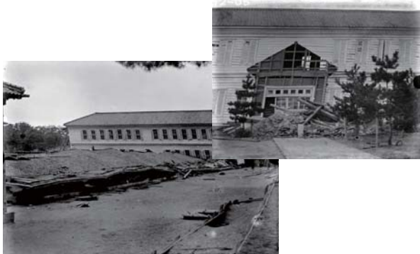
明治27(1894)年の庄内地震で被災した酒田高等学校
