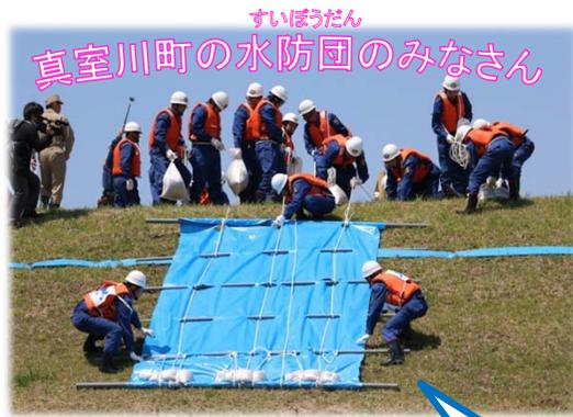
現場の被害を防ぐために、町の水防団に出動してもらう場合もあります。写真は、土手がくずれた場合を想定した訓練をしている様子です。
