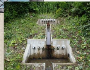
横ポーリング工
