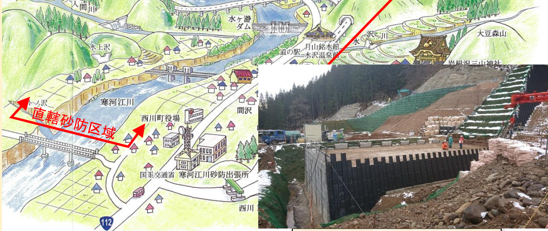
現在工事中の横岫沢砂防堰堤 (令和2年3月時点)
