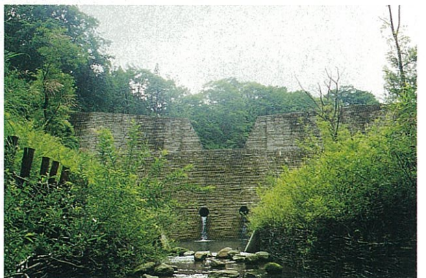
西川行沢えん堤 (平成9年完成)
