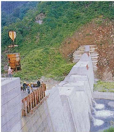
昭和50年代の工事の様子 (四ツ谷第3砂防えん堤)
