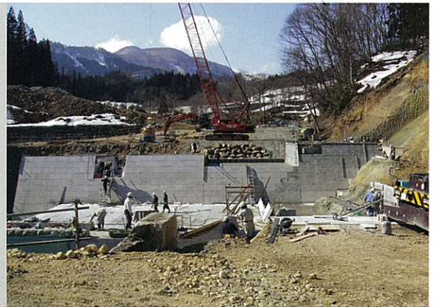
現在の工事の様子 (西川水沢川砂防えん堤)
