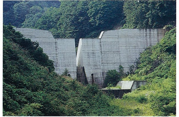
風吹沢第3えん堤 (平成11年完成)
