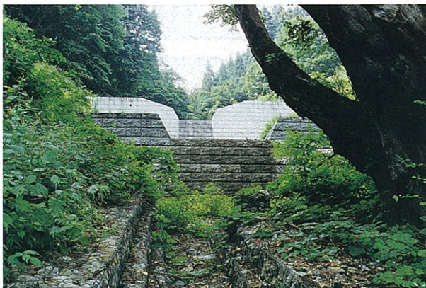
久保入間えん堤 (平成7年完成)
