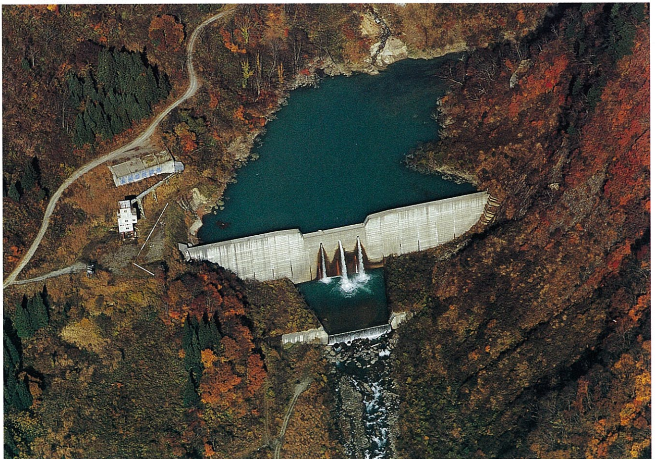
寒河江川流域で、一番コンクリートの量が多いえん堤
