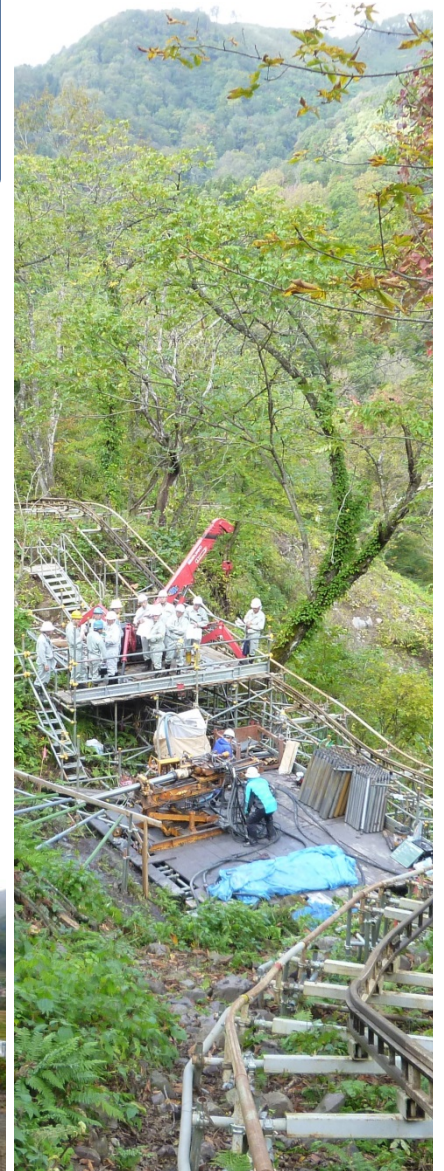
田麦俣地すべり対策工事現場
