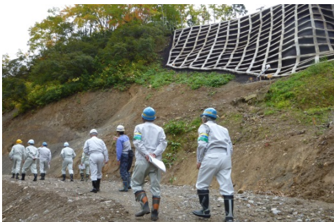
岩菅第七砂防堰堤工事現場
