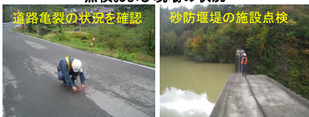
点検および現場の状況
