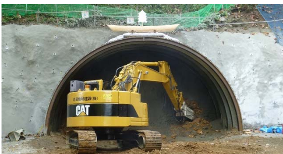
笹根トンネル掘削開始(9月30日)
