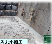
スリット施工完了
