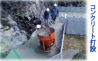
振動を与え締固め中
