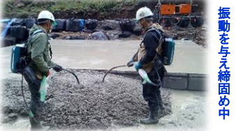
コンクリート打設
