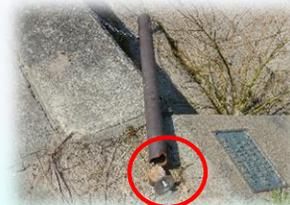
立入防止柵の支柱が根元から破損している
