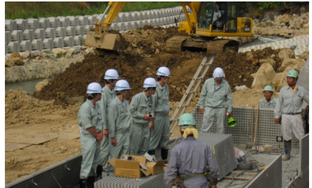
銅山川流域肘折護岸工事現場にて護岸の現場打擁壁工の施工を間近で見学。
