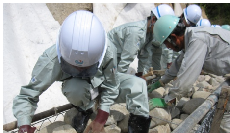
工事現場では作業員からの説明を受け、かごマットの詰石作業を体験。
