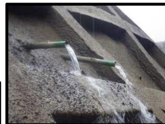
↑法枠工のりわくこう、パイプ打ち込みをし、湧き水を外に排出します。
