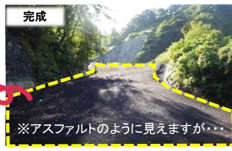
●この法面には植物の種や肥料が混ざった土(植生基材)が吹き付けられており、時間の経過とともに草木が生えて根を張り、法面の浸食を防止します。
