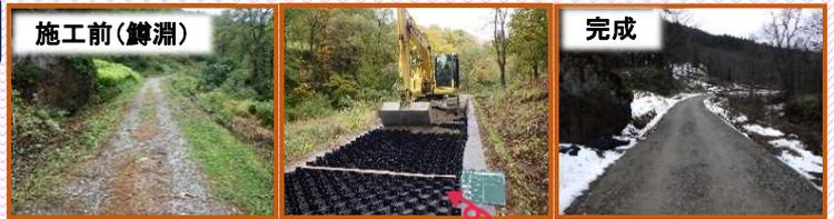
↑元の道路に路面補強材を敷き、グランドセルに砂利を詰め固めました。車が通っても路面が沈まず、わだちがでなくなります。
