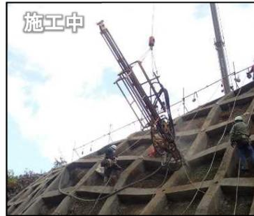
上部からクレーンで削孔機械を吊って作業をしている様子
