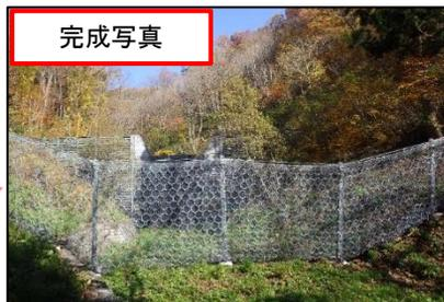
流木を捉えるため、既存の砂防堰堤に鋼製ネットを設置しました。
