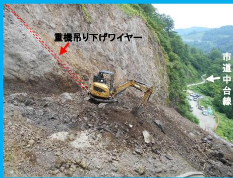
←セツ滝ブロック渓流保全工事の現場では無人のロッククライミングマシンでの施工を実演しました。奥にある道路や駐車場を見ると高所の崖で作業している事が分かります。
