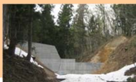
建設中の コヤブ沢砂防堰堤
