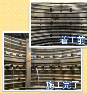
〔集水ボーリング〕
