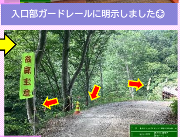
路肩表示(ロープ)のピンを固定し、車両通行の際の明示を追加しました◎
