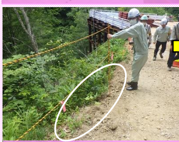
路肩表示(ロープ)のピンがきちんと固定されていない。また、車両通路の路肩の補強・表示を追加すること⇒
