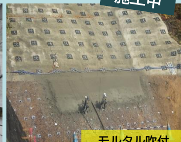
モルタル吹付
