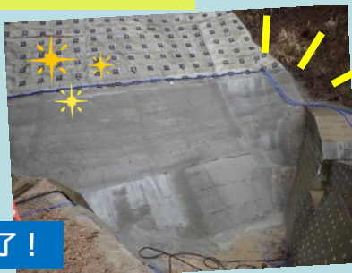
法面を補強する鉄筋挿入工
