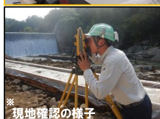
※ 現地確認の様子
