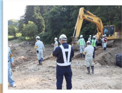
滝の沢第2砂防堰堤での様子
