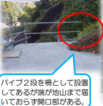
パイプ2段を柵として設置してあるが端が地山まで届いておらず開口部がある。
