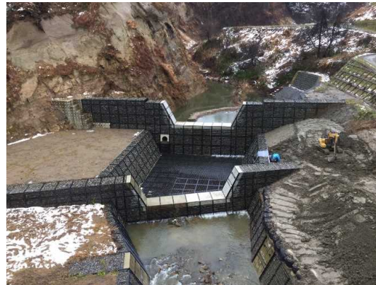
本堰堤・副堰堤（施工中）
