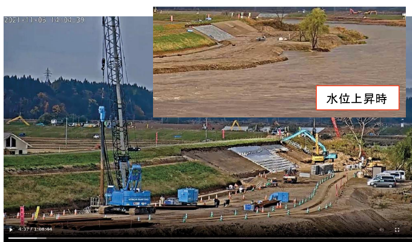
IoTカメラ現場撮影状況
