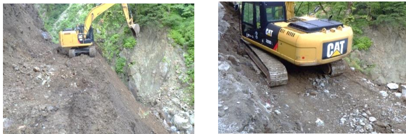
資料5 狭隘道路箇所による施工状況
