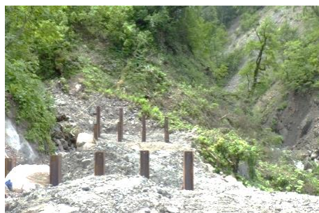
資料1 松沢現場着工前
