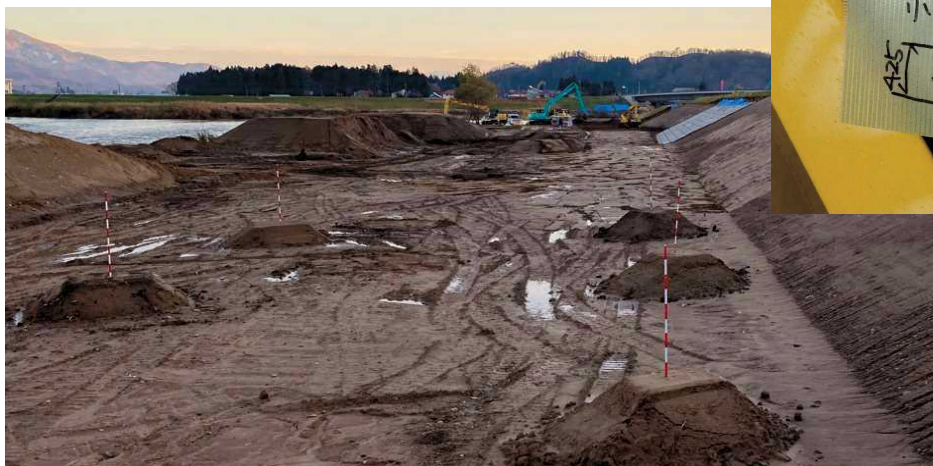
高水敷土砂敷均し前
