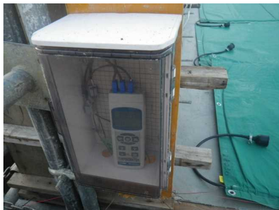
養生温度管理状況
