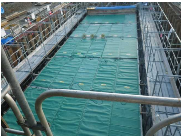
コンガード使用による養生状況
