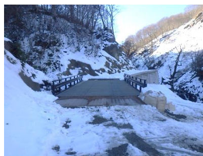
資料2 松沢現場完成
