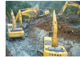
多接続機能を活かした建機の同時施工による施工量の増加
