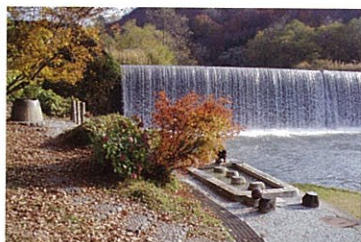
砂防ダムと足湯が隣接している希少事例
