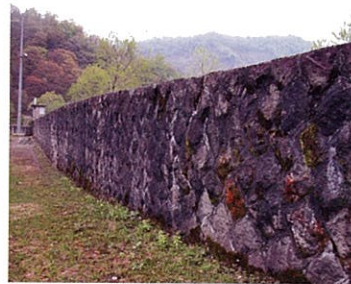
左岸袖部下流側側面/石積
