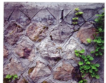
右岸袖部：上流側側面
