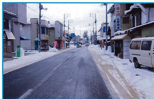
除雪作業がスムーズになり道路も広がって、冬とは思えない幹線道路となりました。
