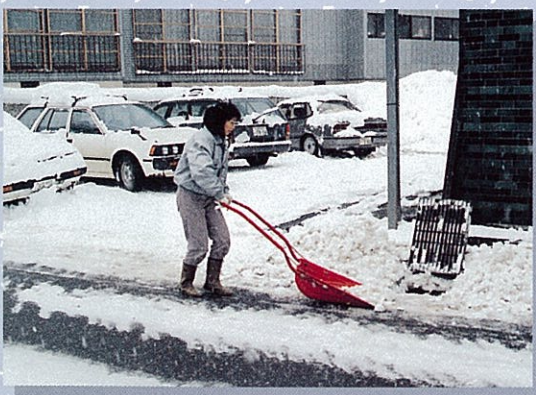
完成した流雪溝への投雪状況
