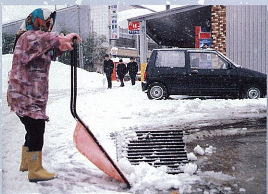
完成した流雪溝への投雪状況
