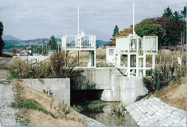
糸出沢放流工
