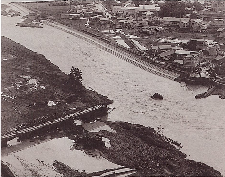
■空から見た真室川及び流失した新橋(昭和50.8.6)
