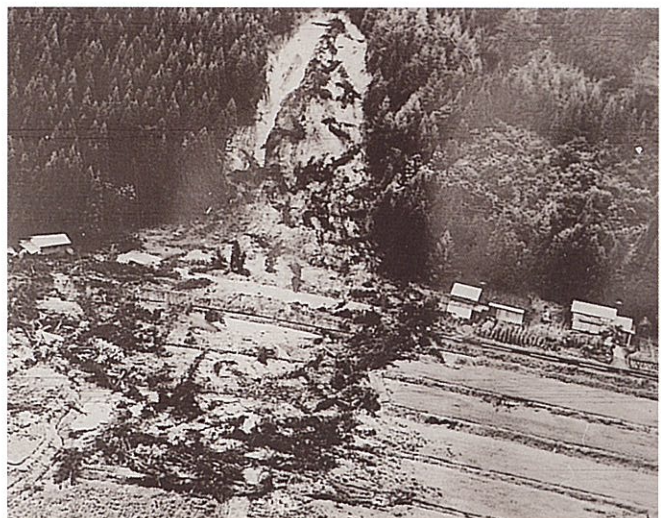
■土砂崩れが発生した旧及位地区(昭和50.8.6)
