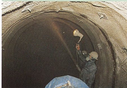
②コンクリート吹き付け
