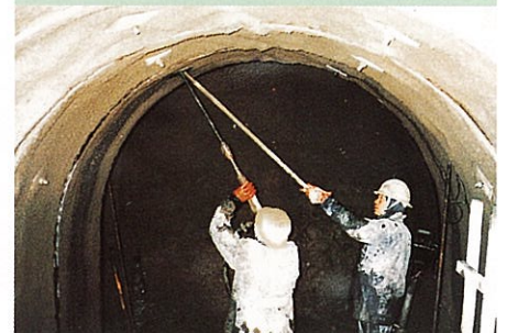
③ロックボルト打設
