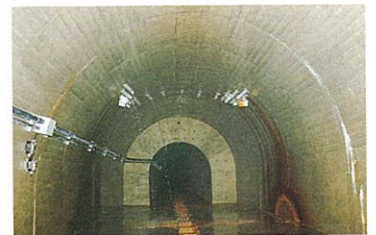
▲排水トンネル内の集水ボーリングからの集水状況
