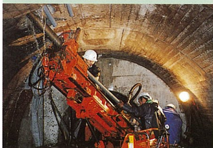
⑤集水ボーリング
