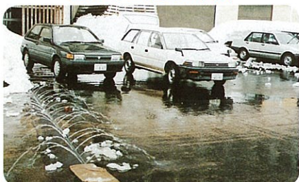
駐車場の消雪の状況
