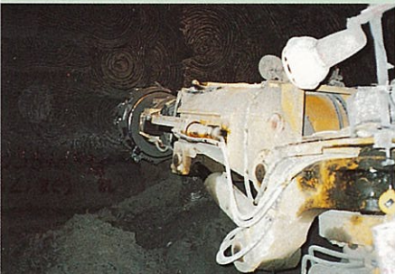
①機械によるトンネル掘削
