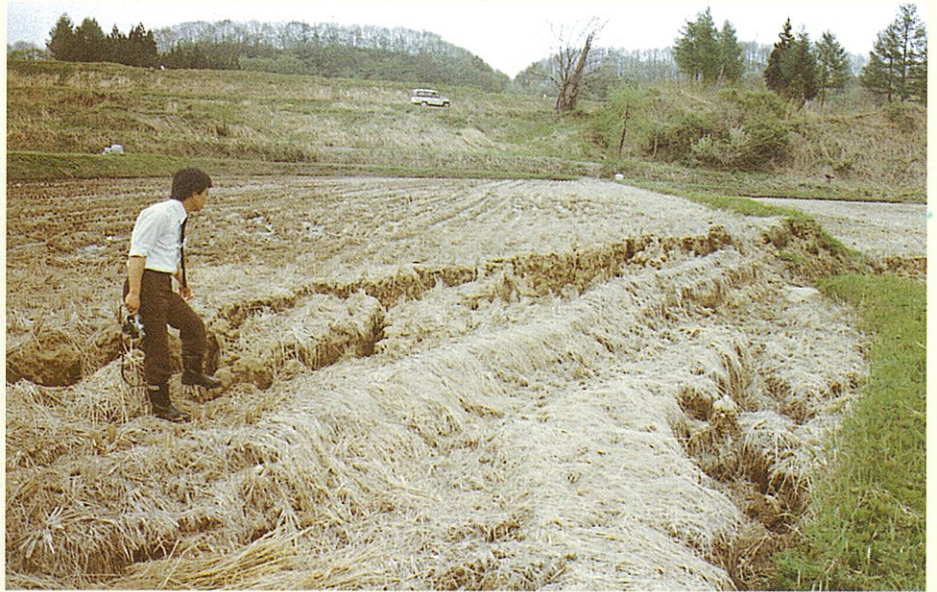
平根地すべり被災状況(昭和53年)
