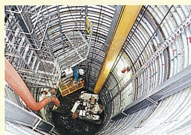
集水井工(ロボット掘削)
