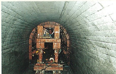
コンクリート打設状況
