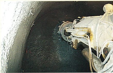
トンネル掘削状況
