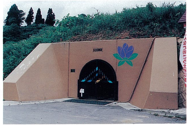
排水トンネルの正面
