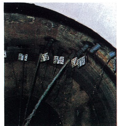
試錐座部からの集水状況
