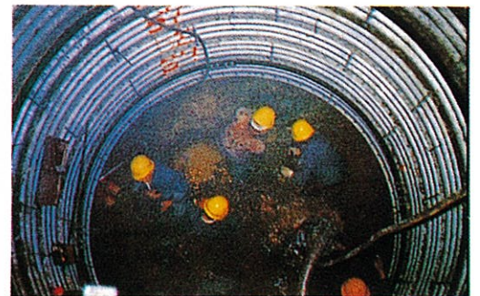
集水井の施工状況
