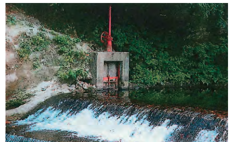
写真 20-2 赤松川につくられた赤松開墾堰の取水口 現在の取水口は、初めの場所より少し下流に移動しています。
