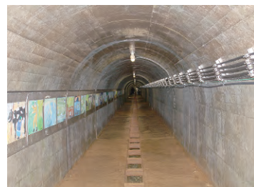
写真 36-6 排水トンネルの中
