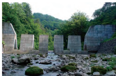
写真 35-4 肘折第2砂防堰堤(透過型)
