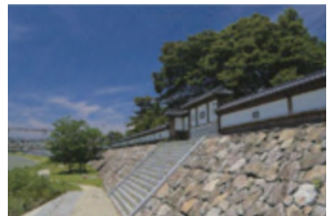
写真 16-2 むかしのすがたを再現した大石田河岸（山形河川国道事務所 HP より）
