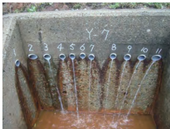
写真 36-2 横ボーリング工
