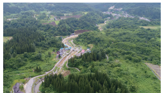
写真 35-6 苦水川の渓流保全工
