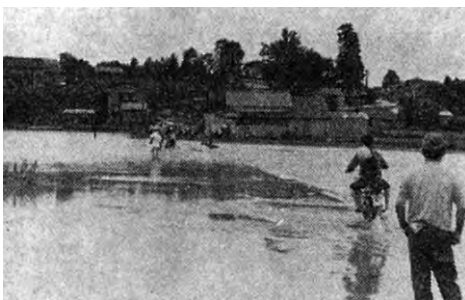
写真 25-2 昭和41年台風4号災害で水につかった道路(旧大蔵橋-白須賀間)
