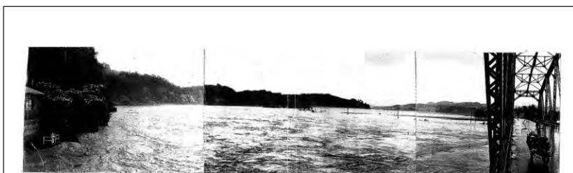
写真 24-4 昭和 44 年 8 月の豪雨で増水した銅山川 （旧大蔵橋右岸から上流を見たところ）
