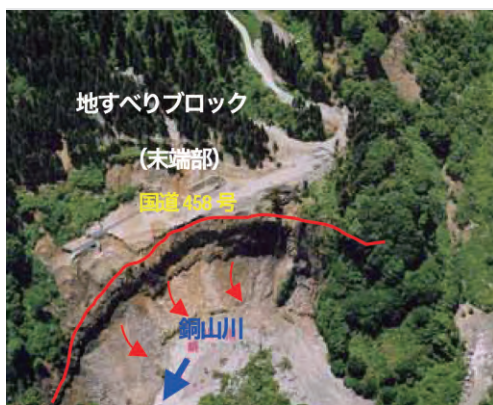
写真 30-1 平成 8 年に湯の台で発生した地すべり すべり落ちた大量の土砂が銅山川に流れ込みました。
