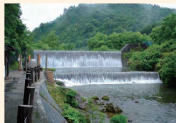
写真 34-3 肘折砂防堰堤 堰堤の下流右岸側は公園になっていて、たくさんの観光客も訪れます。
