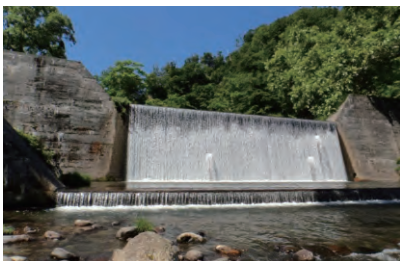
写真 35-1 赤松第2砂防堰堤(不透過型)
