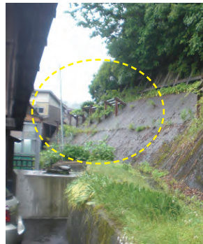
写真 37-2 住宅のすぐ後ろにある雪崩予防柵(肘折地区)
