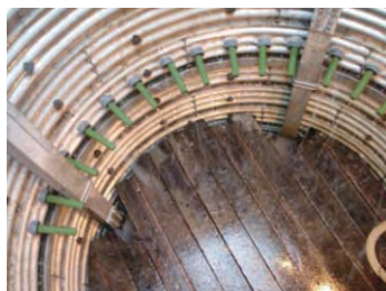
写真 36-5 集水井の内部
