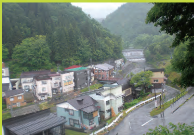
写真 44-2 現在の肘折温泉街と肘折堰堤（2018年）
