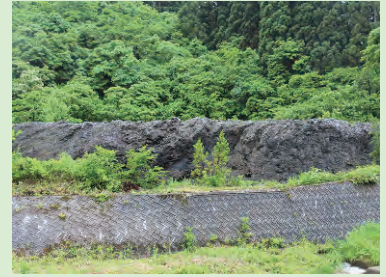
写真 19-1 カラミの固まり(左)と積み重なったカラミ(右) カラミは底のとがったバケツで運んでいたため、バケツの形に固まっています。
