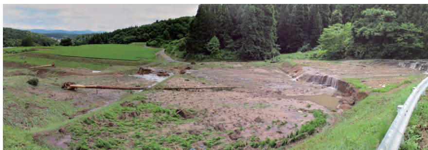
写真 27-2 ため池が決壊し下流の水田に大量の水と土砂が流入
