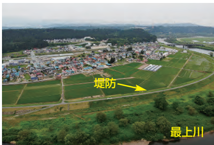
写真 37-3 最上川の堤防 堤防の上は道路になっています。
