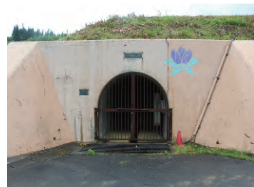
写真 36-3 排水トンネルの入口
