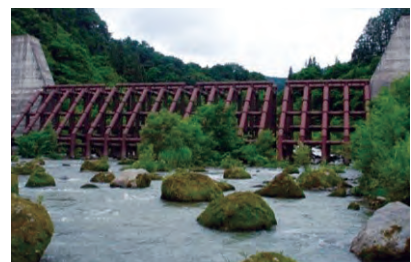
写真 35-5 ますだ第2砂防堰堤(透過型)
