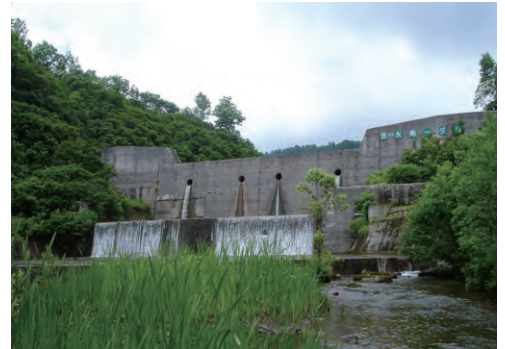
写真 34-1 苦水第1砂防堰堤
