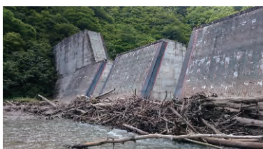
写真 34-2 流木をとらえた烏川第3砂防堰堤 流木は破壊力が大きく、橋の上流にたまったりすると流れをせき止めて、周囲が浸水することもあります。
