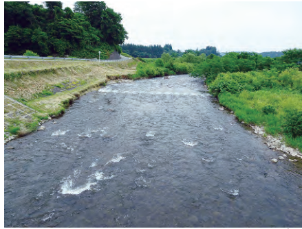
写真 7-1 南山地区を流れる銅山川大浦橋から下流を見たようす
