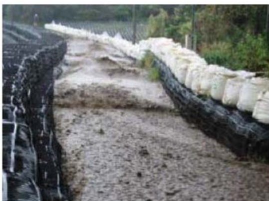
大型土のうによる仮導流堤の例 (三宅島)
