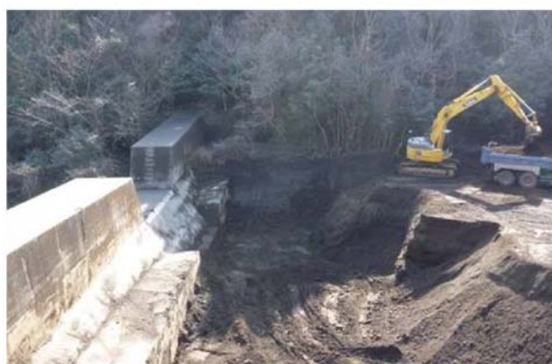
既存堰堤の緊急除石の例 (霧島山)
