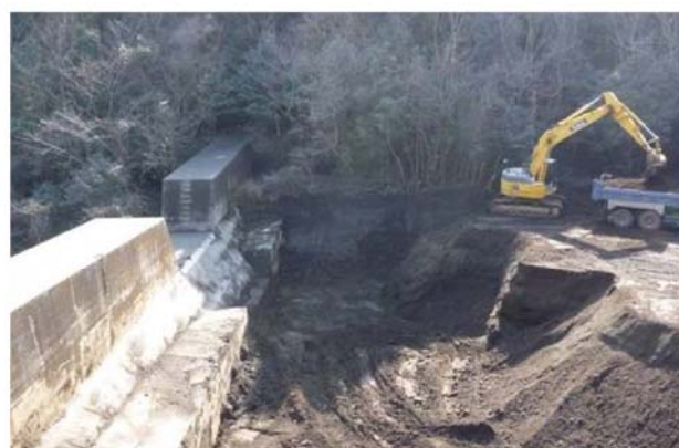
既存堰堤の緊急除石の例 (霧島山)
